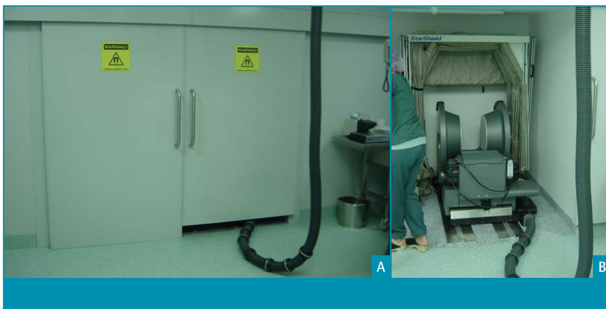
Figuur 1. Plaats van de intraoperatieve lage veldsterkte MRI in de OK. De MRI is geïnstalleerd in een afzonderlijke kleine ruimte die grenst aan de OK in een kleine kooi van Faraday, omdat de MRI een continu magnetisch veld heeft (permanente magneet). Opgeborgen in de ruimte is de OK een algemene OK die beschikbaar is voor alle disciplines.
